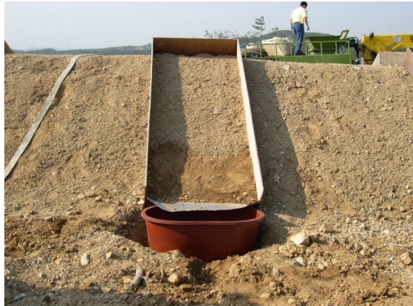
사진 3.3 토사유출량 모형제작틀 설치 전경
